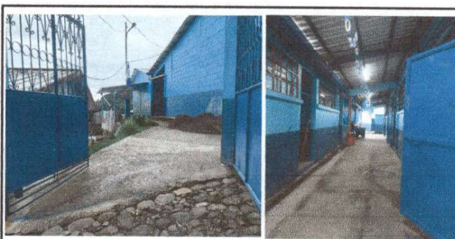
Foto 12: Mantenimiento a estructura, portón y puertas
