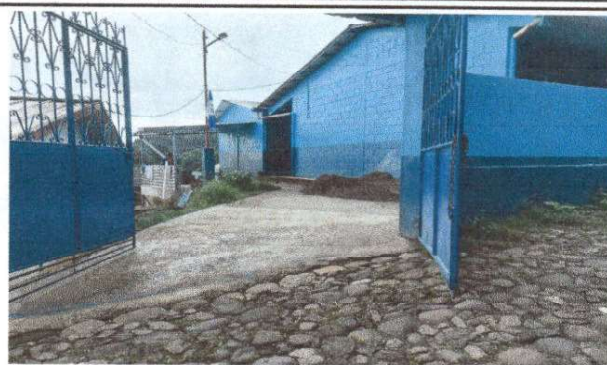
Foto 8: Reparación de banqueta de concreto.
