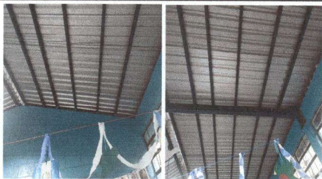
Foto 9: Sustitución de láminas troqueladas.
