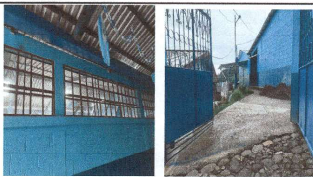
Foto 11: Pintura en muros interiores y exteriores.
