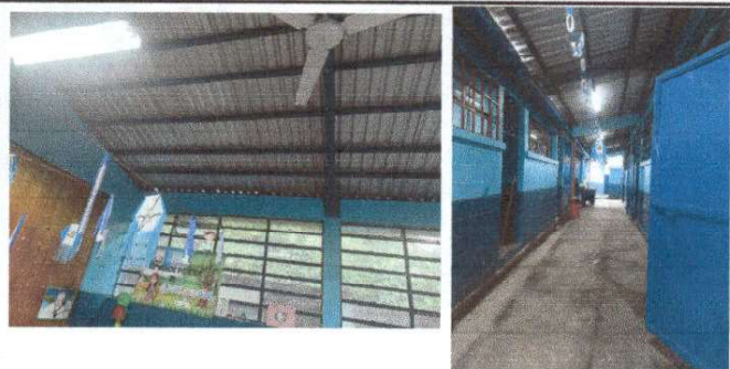
Foto 7: Sustitución de lámparas aulas y corredor.
